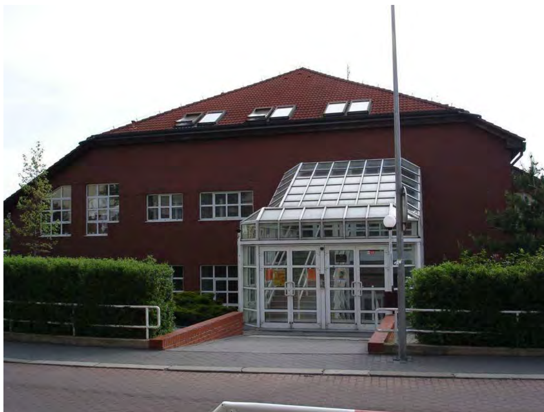
foto nahoře: budova školy a hlavní vchod, dole: vstup do jídelny a školní družiny
